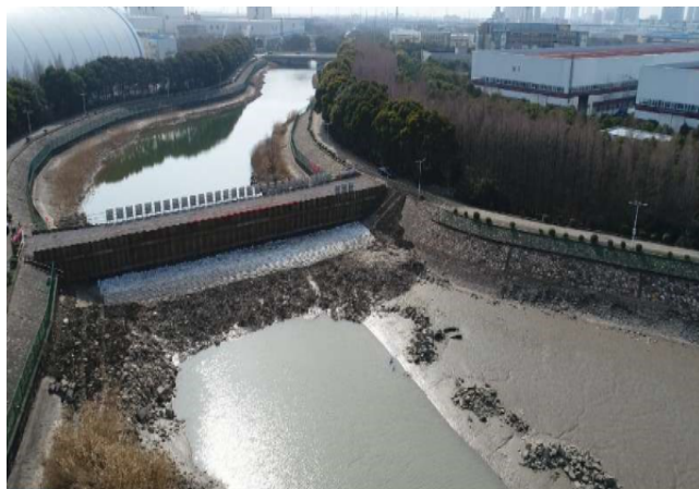
图5 外河围堰完工现场图
