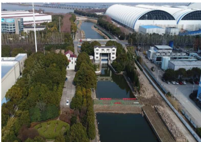
图6 内河围堰完工现场图
