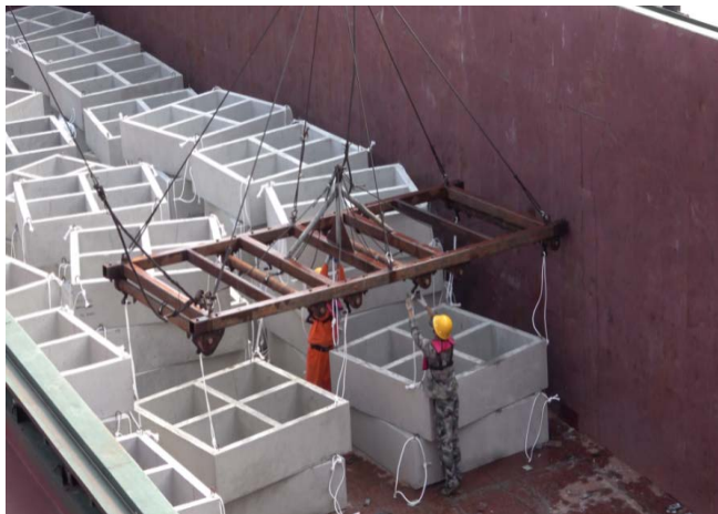
图12 透空格栅鱼巢排吊装
