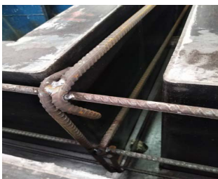
图7 钢筋骨架放于钢模平面中间
