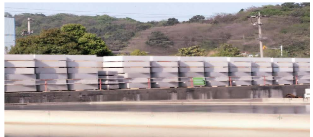
图11 透空鱼巢排横向躺式堆放
