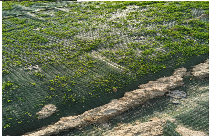
图9 施工现场的照片
