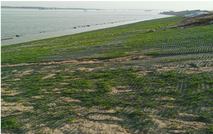
图8 施工现场的照片
