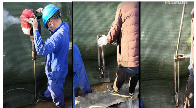
图 7 特拉锚施工
