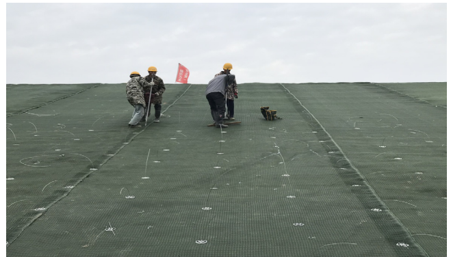
图 6 特拉锚施工
